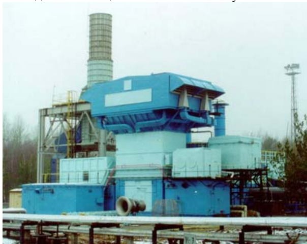
Рис. №1 КВОУ для газоперекачивающего агрегата ГПА-16 «Нева». Первая ступень – прямооточные мультициклоны, вторая ступень – карманные фильтры. 1990-е годы, ОАО «ВНИИТрансмаш».
